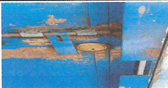
Foto 2: sustitución de chapas de puertas
