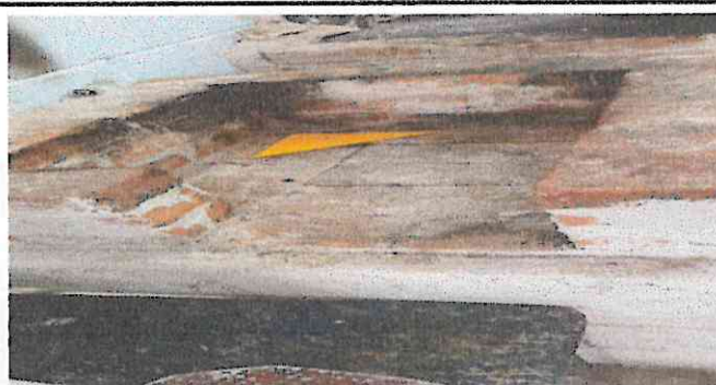
Foto 8: reparación de estufa rural
