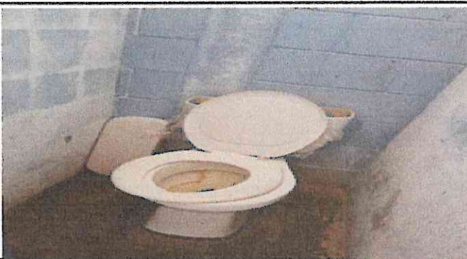
Foto 12: cambio de sanitarios por deterioro.
