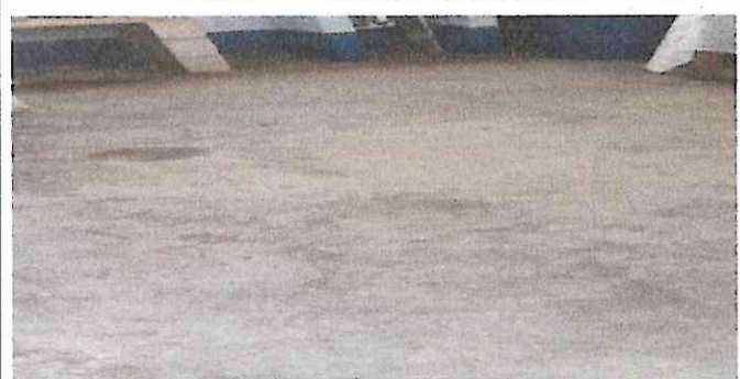
Foto 3: sustitución de piso de concreto por cerámico antideslizante en cocina y sanitarios
