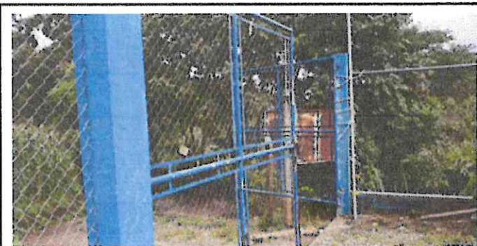
Foto 5: sustitución de portón de metal
