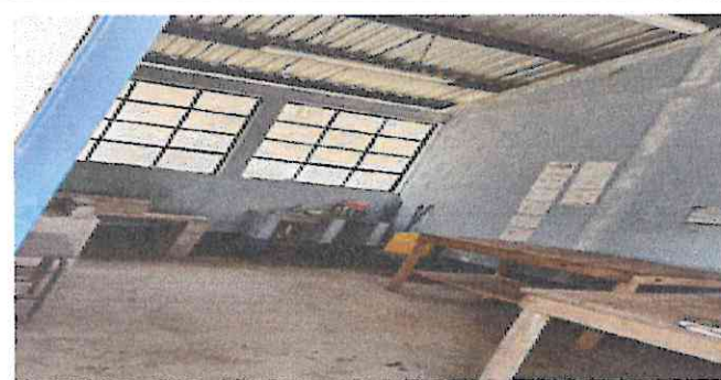
Foto 9: Implementación de mueble de concreto en cocina
